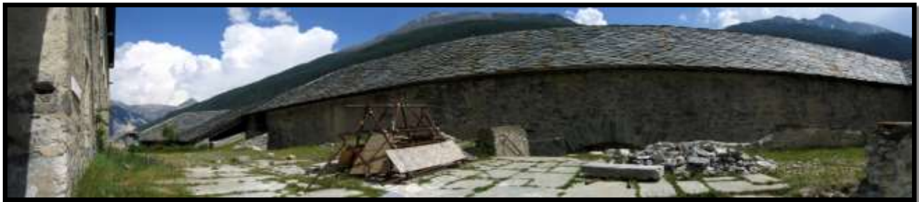
Sous l'échafaudage, l'une des deux citernes du Fort Victor-Emmanuel
