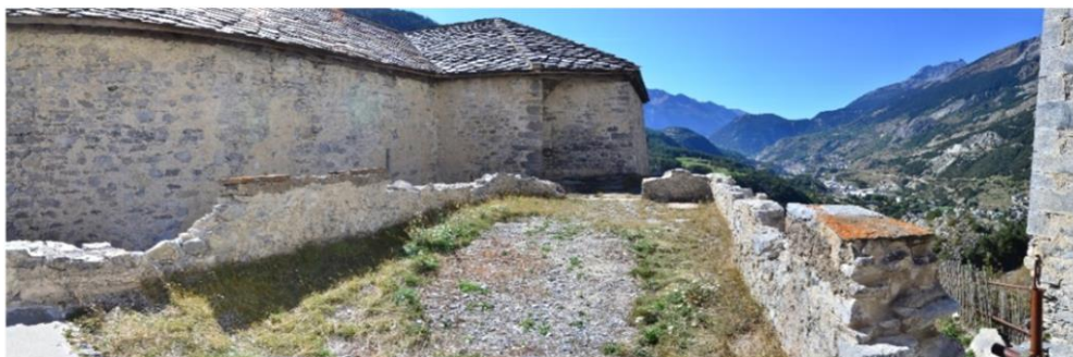
Accès à la toiture, côté Est
