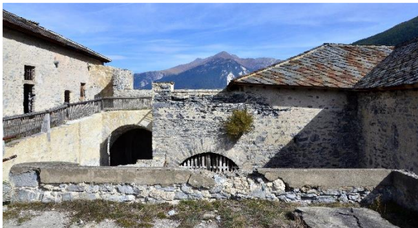
Muret au niveau de la terrasse
