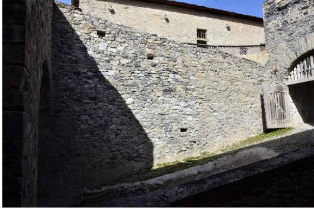
Mur de la rampe d'accès au portail
