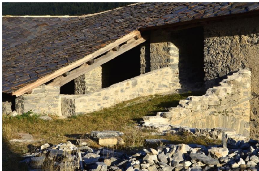
Accès à la toiture, côté Ouest
