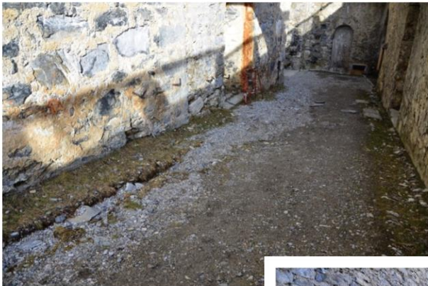
Entretien du cheminement du Fort ...
