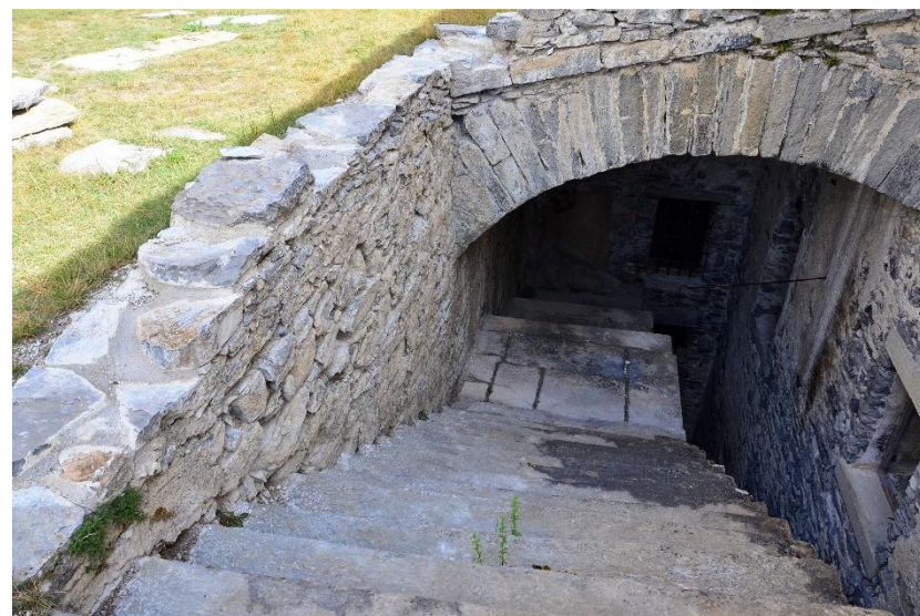
L'escalier descendant vers la Salle de Douches,
