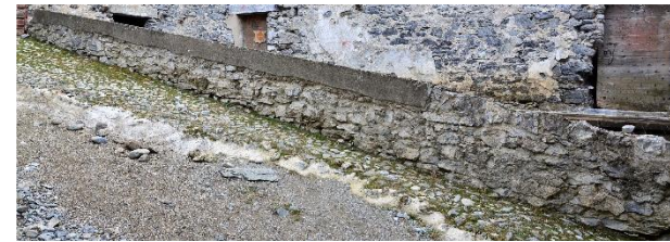
Muret le long de la rampe
