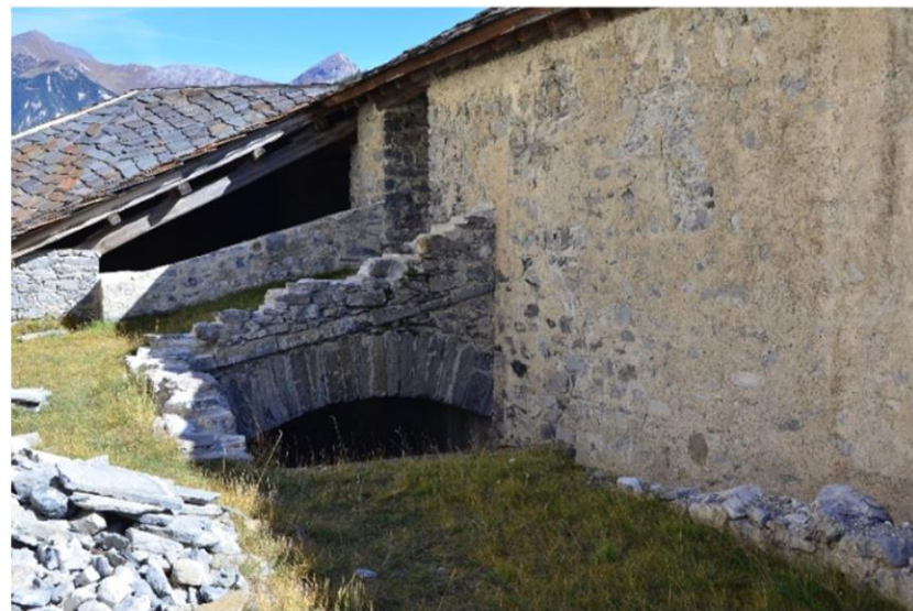
Accès à l'escalier descendant vers la Salle de Douches
