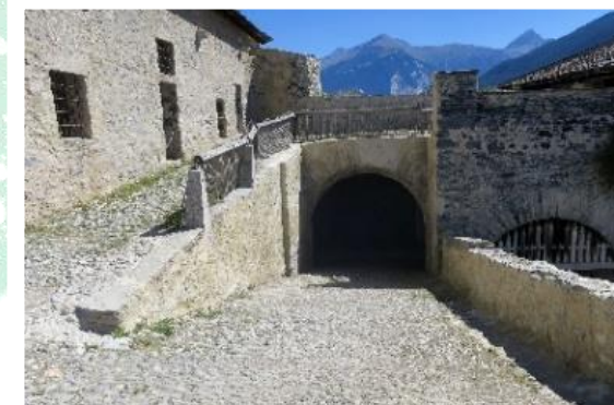
... avant et après les travaux de maçonnerie entre 2018 et 2022
