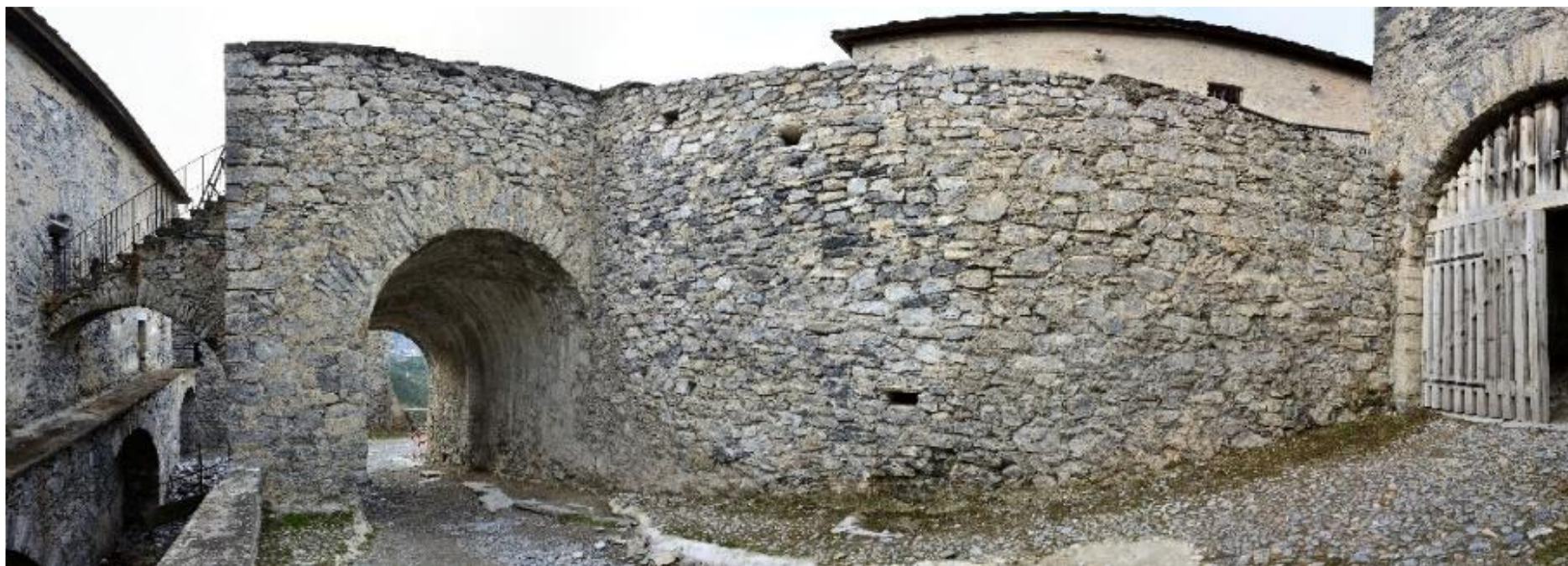
Vue d'ensemble des murs concernés par le chantier de maçonnerie
