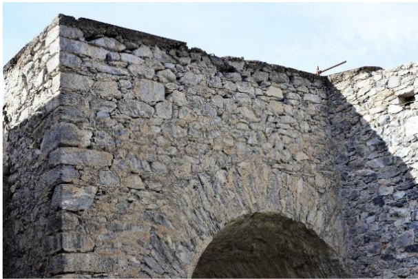
Mur au-dessus de l'arc de la voûte
