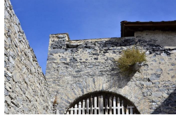
Mur au-dessus du portail
