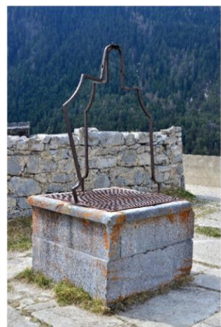
La margelle complète, entrée de la deuxième citerne
