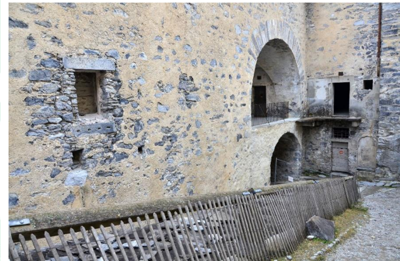
La fenêtre et l'angle des murs du Commandement et de la rampe d'accès
