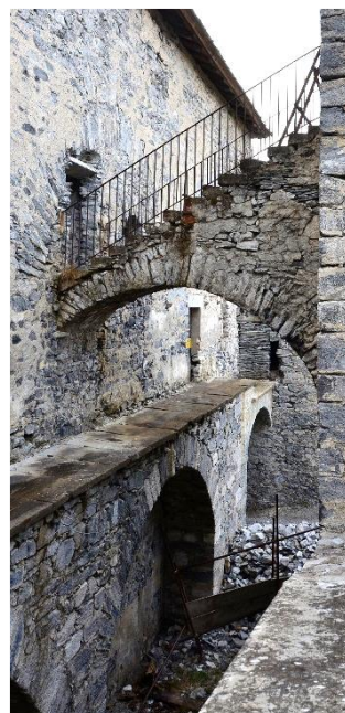
L'escalier dans le couloir sanitaire du Bâtiment du Fourrier
