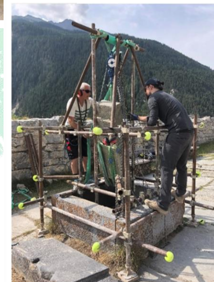
Type de l'échafaudage utilisé en 2019 et 2022, la sécurité s'effectue comme en via-ferrata, baudrier et longes
