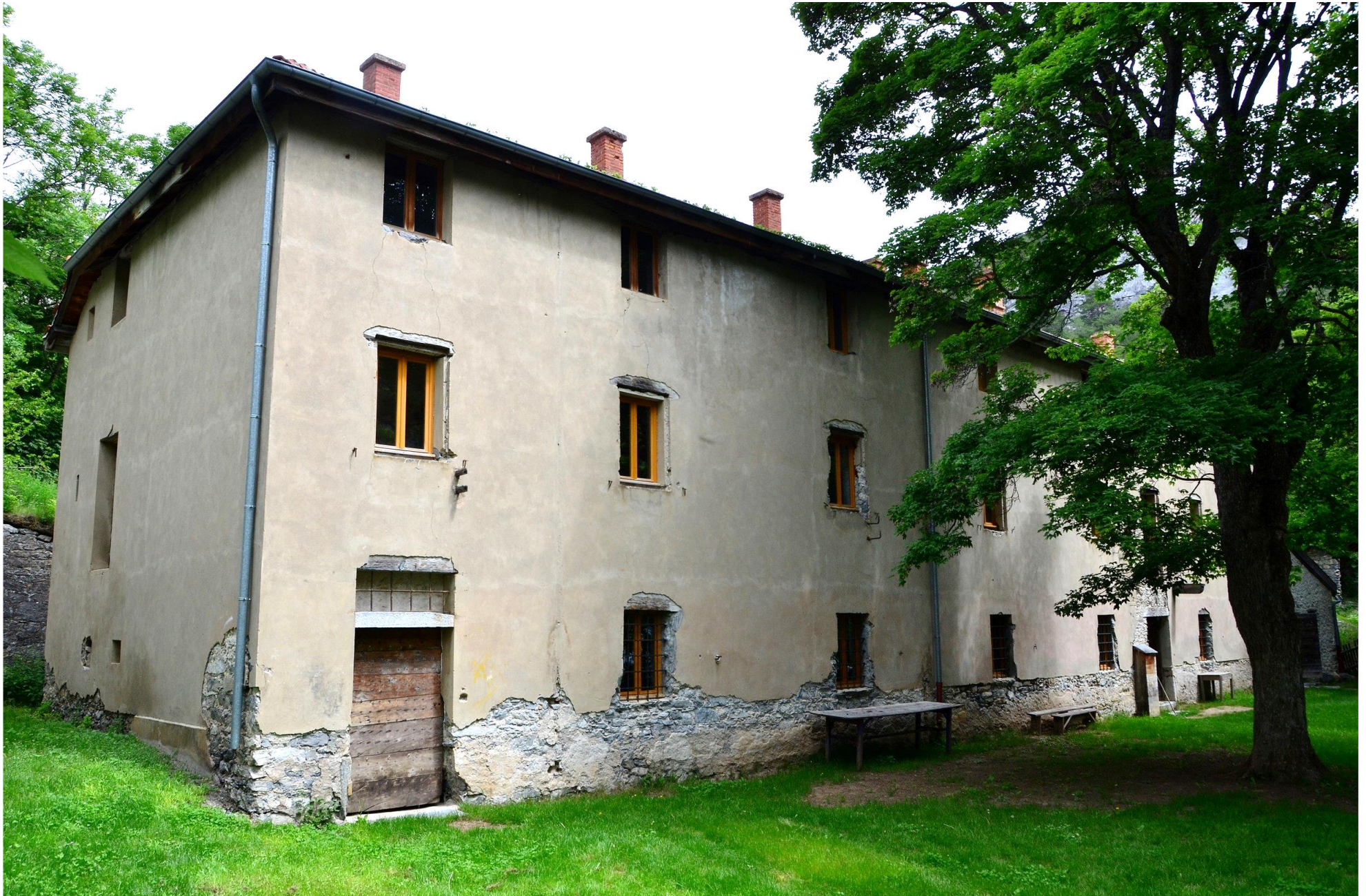
L'avant du bâtiment
