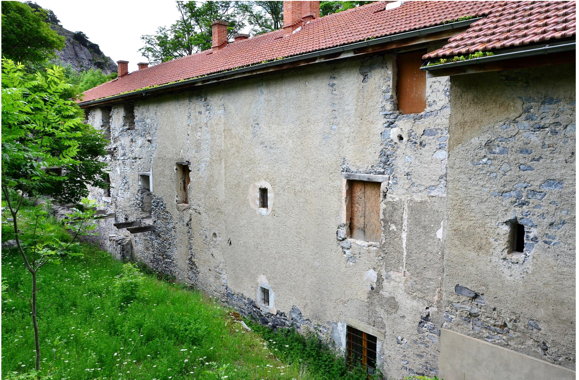
L'arrière du bâtiment
