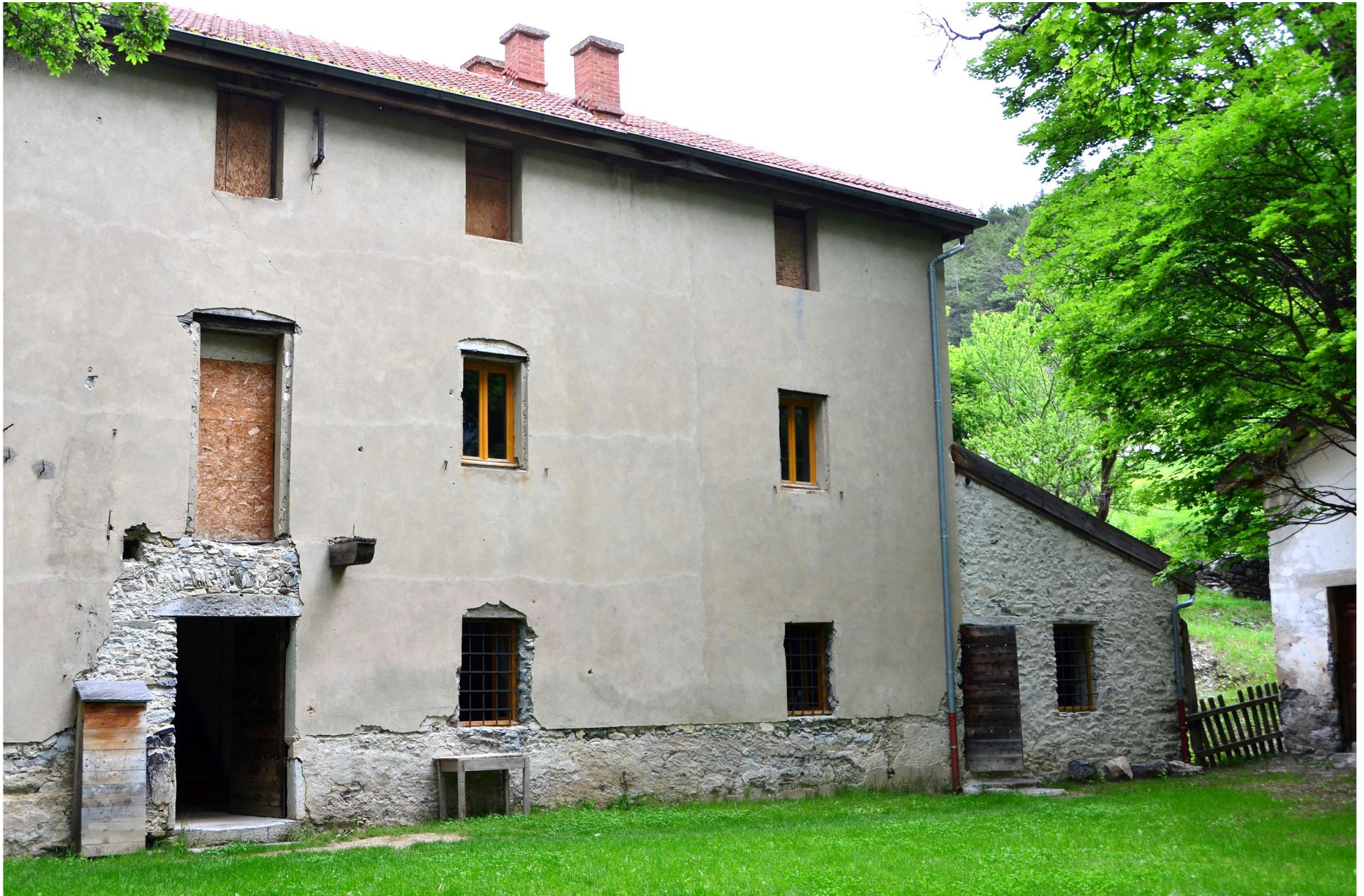
L'avant du bâtiment
