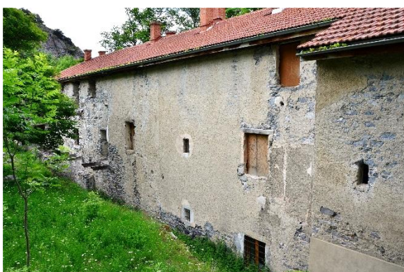
L'arrière du bâtiment, et son couloir sanitaire, côté route
