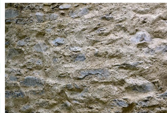
Détail d'un des murs repris 2020
