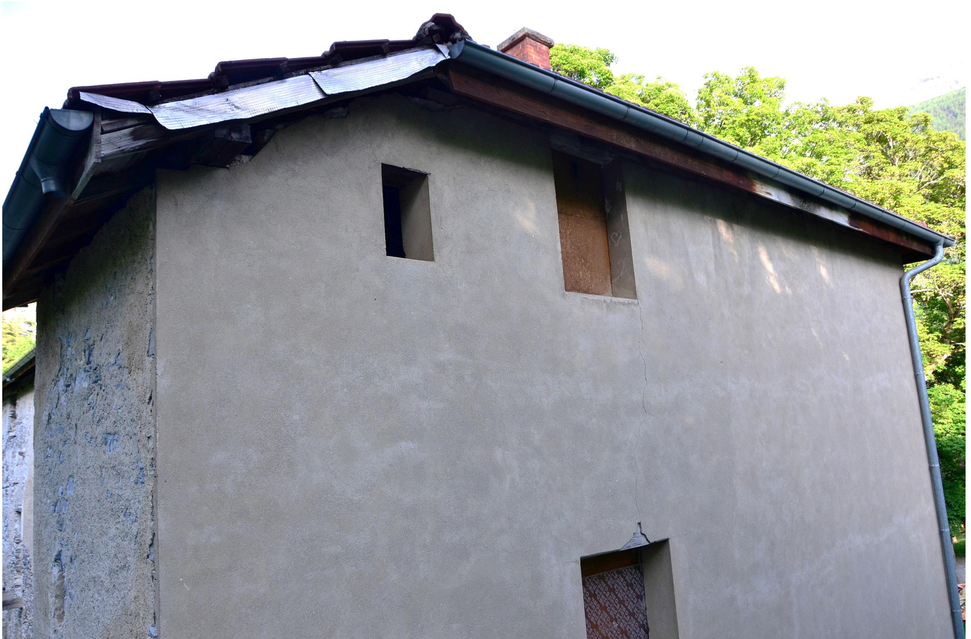
Côté ouest du bâtiment
