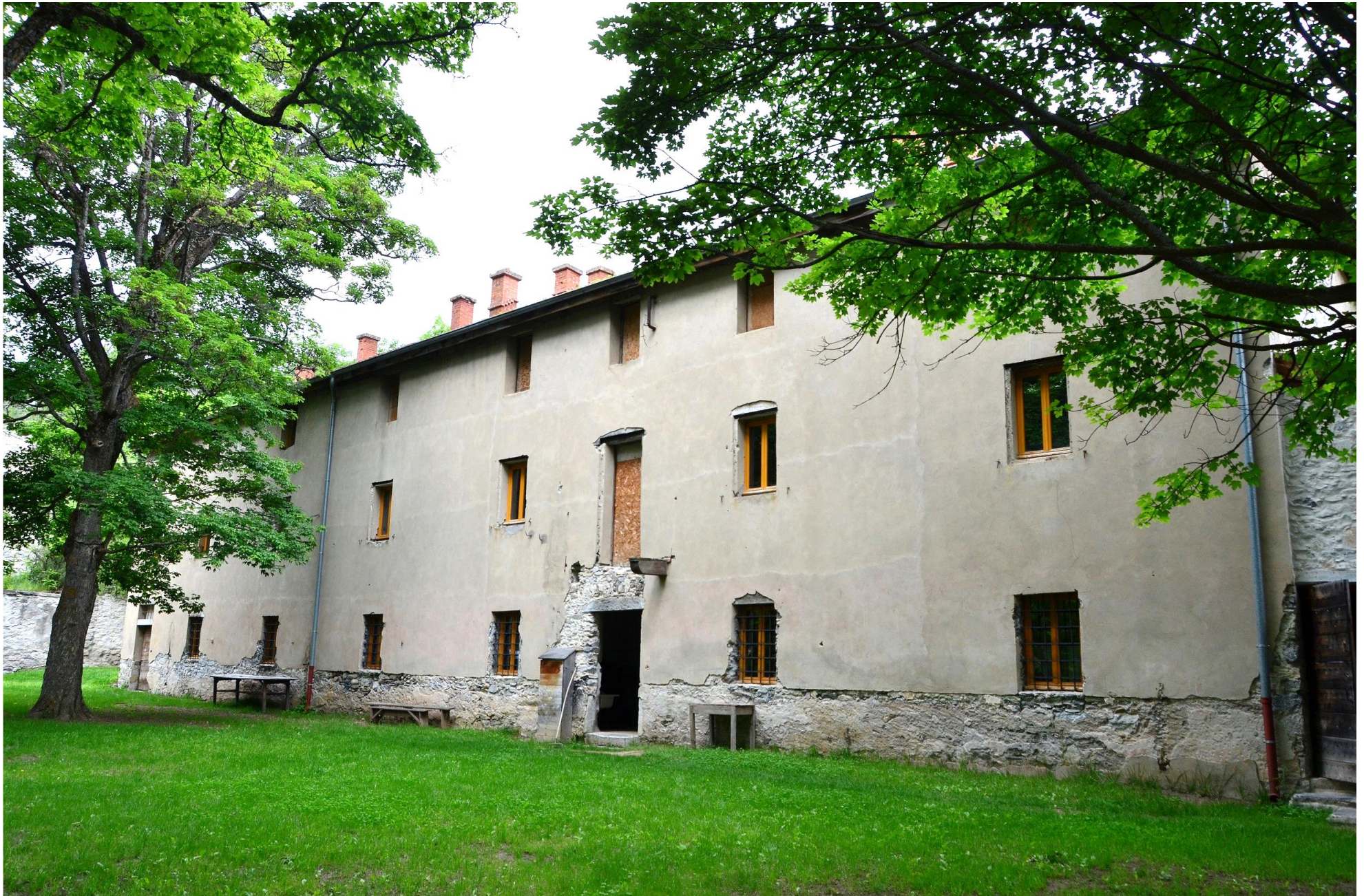
L'avant du bâtiment
