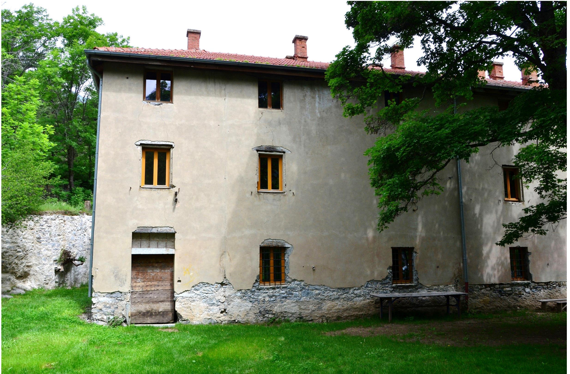
L'avant du bâtiment
