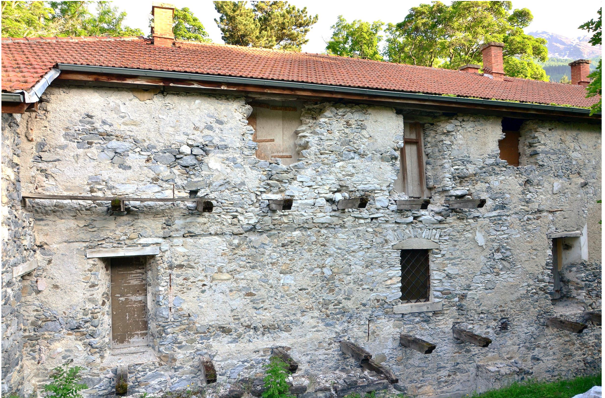
L'arrière du bâtiment
