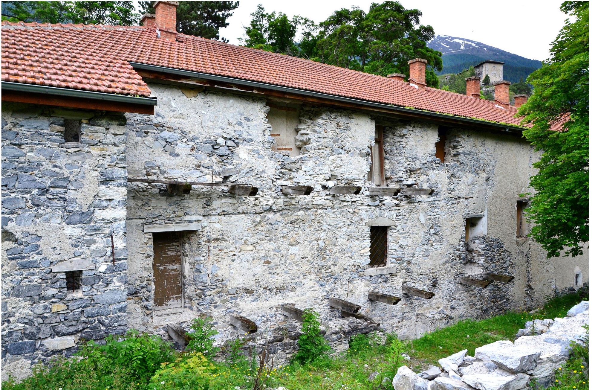
L'arrière du bâtiment
